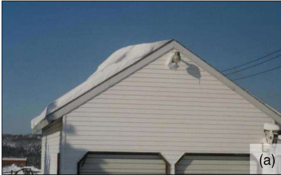
Рисунок 34 – Характерный снеговой мешок на двускатной крыше (из [140])
